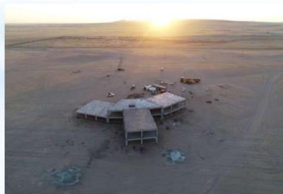
**Хүчин чадал:** Уг барилга нь зоорьгүй, тэнхлэгээрээ А блок нь 20.0x15.2м, В блок нь 12.8x15.2м, С блок нь 20.0x15.2м, D блок нь 19.2x12.8м харьцаатай 2 давхар, цутгамал төмөр бетон араг бүтээцтэй барилга
